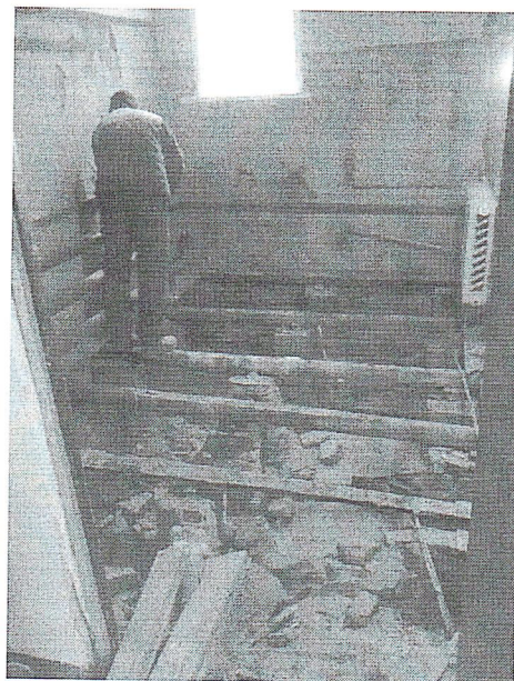
Ремонт комнаты спортивного сектора
